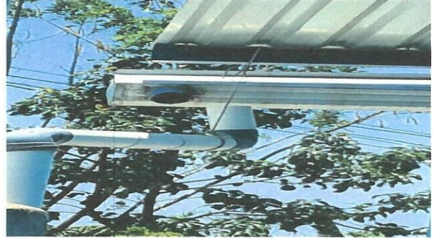
Foto 2: Mejoramiento de caídas de agua
