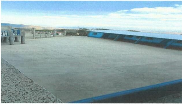
Foto 1: Estructura de techo tipo pórtico y cubierta de lámina calibre 26 troquelada
